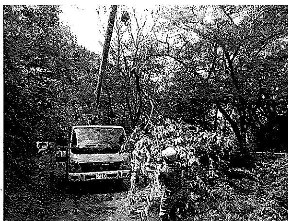
桜苗木の植樹前に、老木、雑木を伐採処理(6/28)
